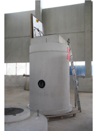
Pumpenschacht DN 1500 mit Auftriebs-sicherung, Dom und Edelstahlabdeckung
