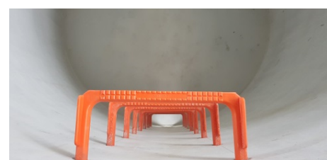
Pumpenschacht DN2500 mit Steigbügel (Edelstahl PP-Ummantelt)
